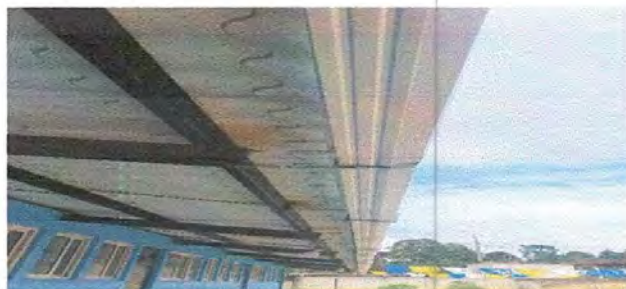
Foto 5: Sustrucción de canales de PVC por metal
