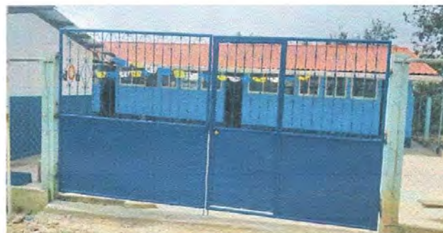
Foto 2: Sustrucción de portón de metal con chapa de 5 mts. De ancho por 2.30 mts. De alto
