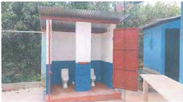
Foto1: Sustrucción de sanitarios y accesorios.
