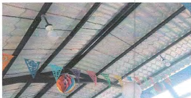
Foto 3: Sustrucción de focos ahorradores
