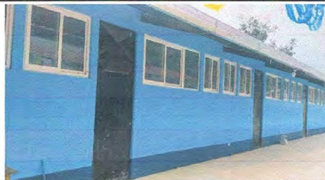
Foto 4: pintura en muros exteriores e interiores.
